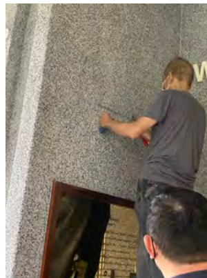
▲ 每館掛置牆面均不相同，需由專業師傅協助掛置固定
